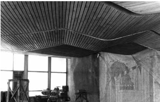
17 pav. „Nendrės“ restorano lubos statybos metu 1981 m.
