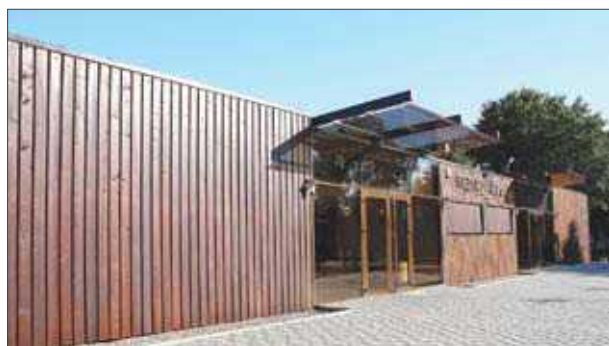
3 pav. Laidojimo paslaugų biuras Radvilų g. 8a, Kėdainiuose, 2007 m. Archit. R. Vieštautas, V. Špečkauskas, D. Čiuta
