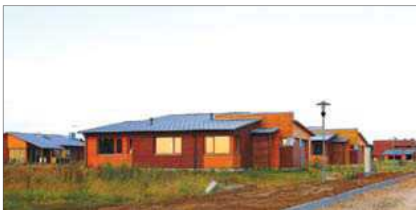
29 pav. Gyvenamųjų namų kvartalas Pavešėčių kaime, 2006 m. Archit. Ž. Lipskis
